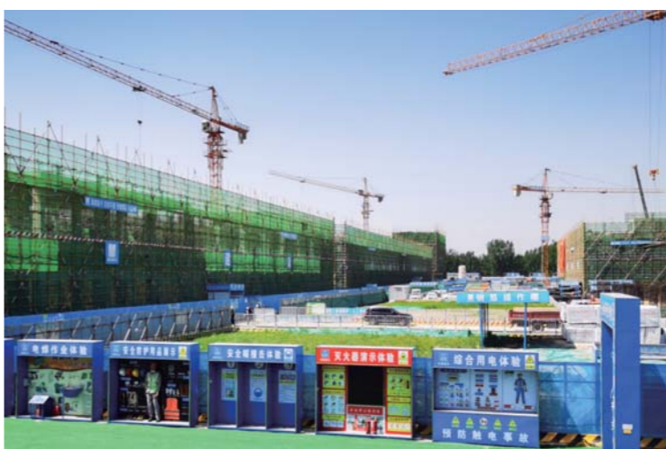
建设中的万泽冷链项目
