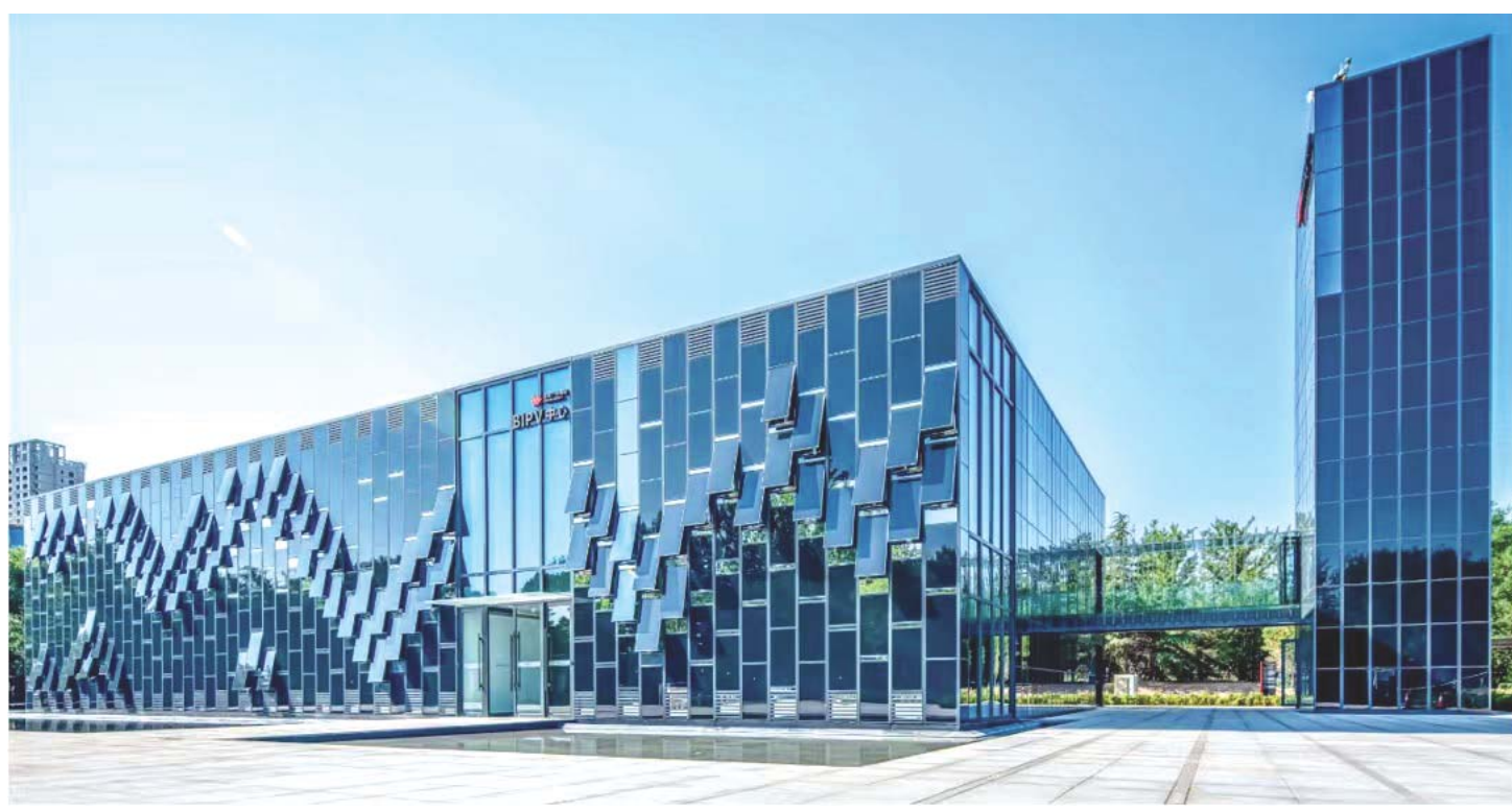
▲北京BIPV中心 ◆2019年世界园艺博览会 碲化镉薄膜光伏屋顶
