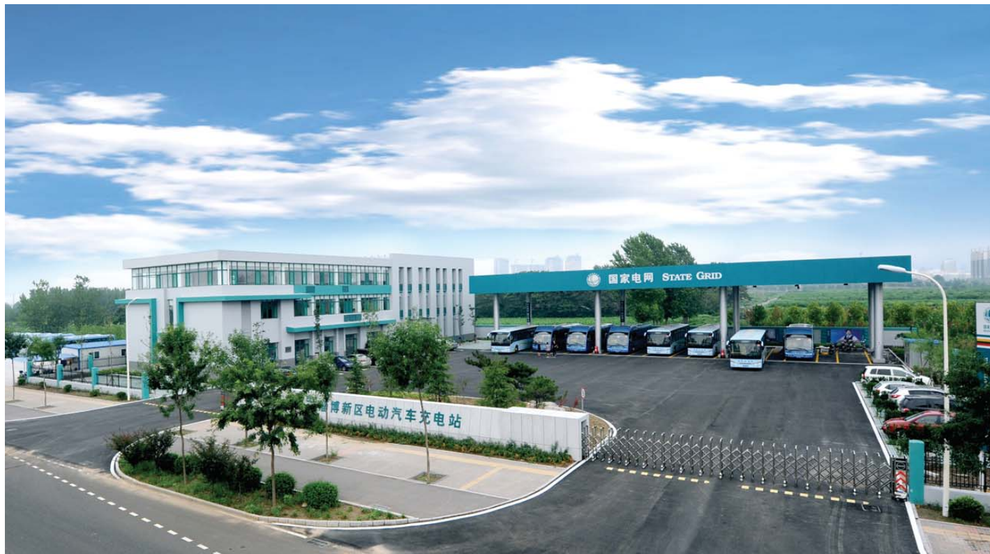
淄博新区电动汽车充电站。
