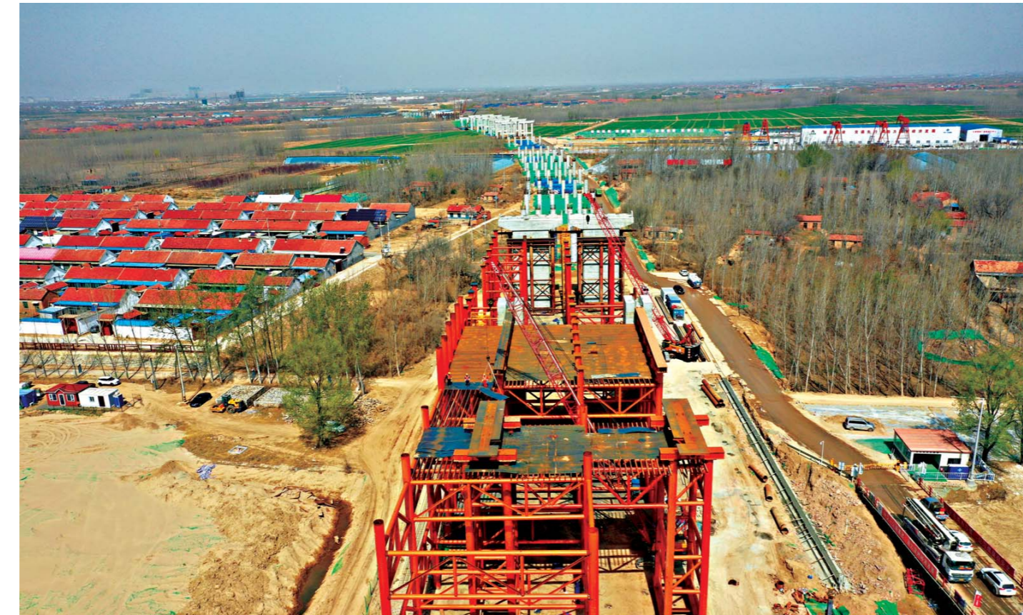
4月7日上午,在沾临高速黄河特大桥项目北塔40号墩处,多名工人正在进行塔座钢筋和塔柱钢筋的模板安装。
