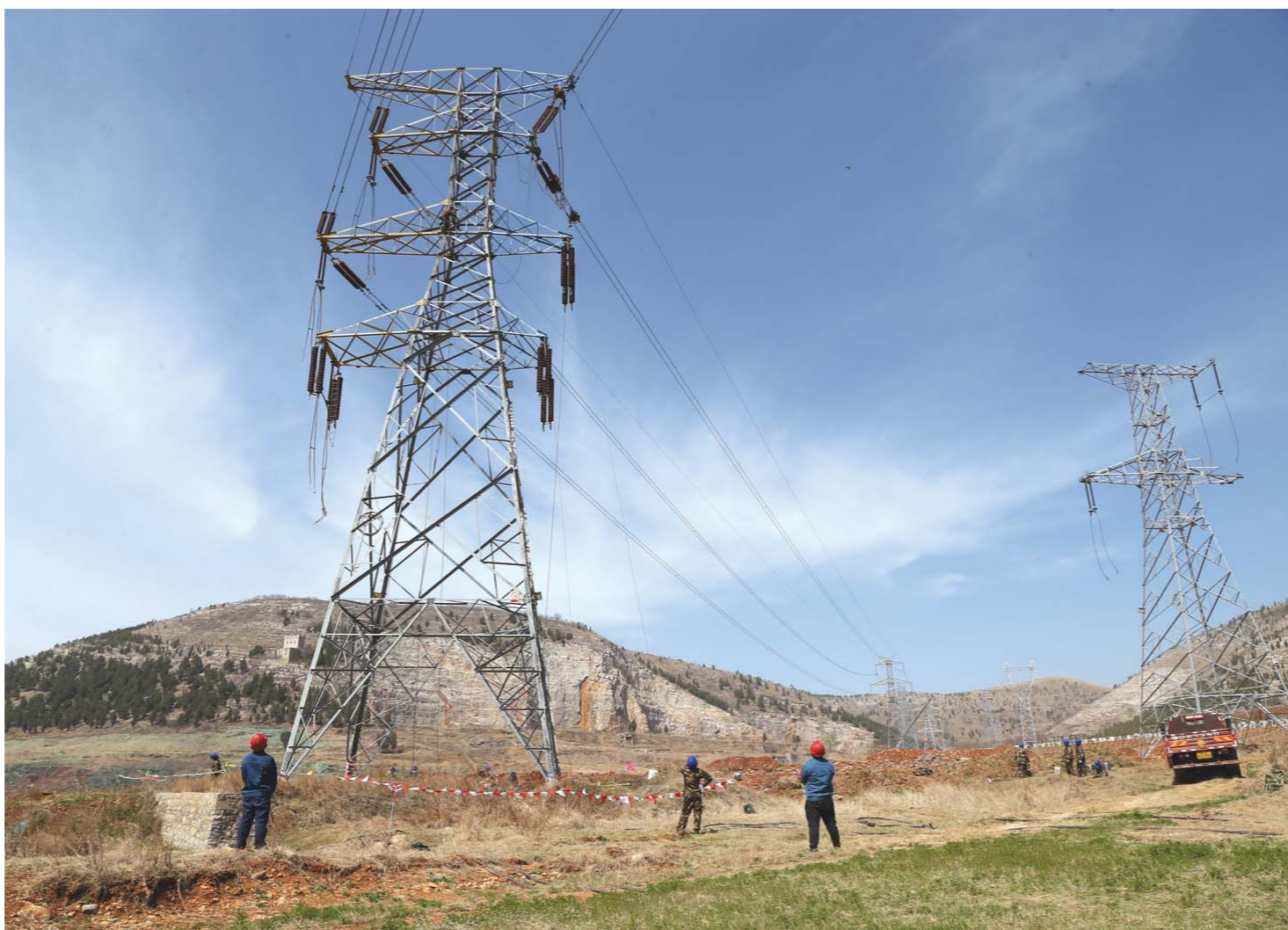
迁改施工现场
