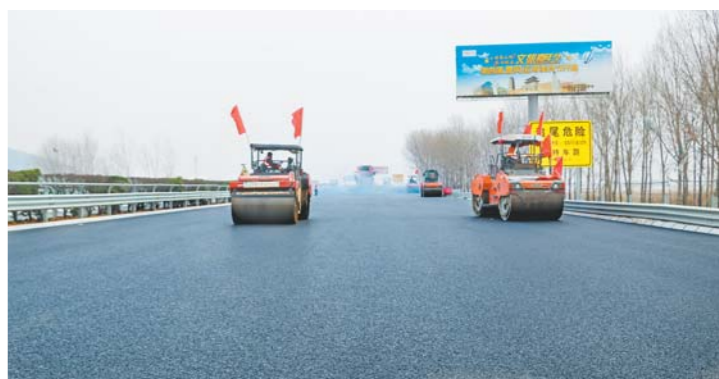
□记者 常青 报道 近日,京台高速泰安至枣庄段改扩建项目施工五标顺利完成1公里路段上面层摊铺,这标志着项目路面工程正式进入最后冲刺阶段。
