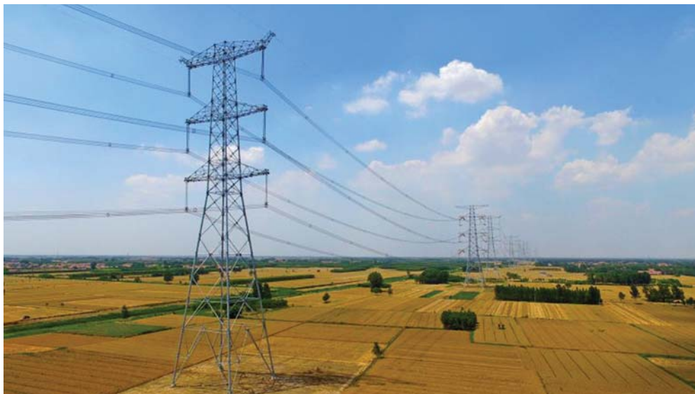
1000千伏锡盟—山东特高压工程。
