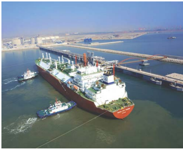
青岛LNG接收站
