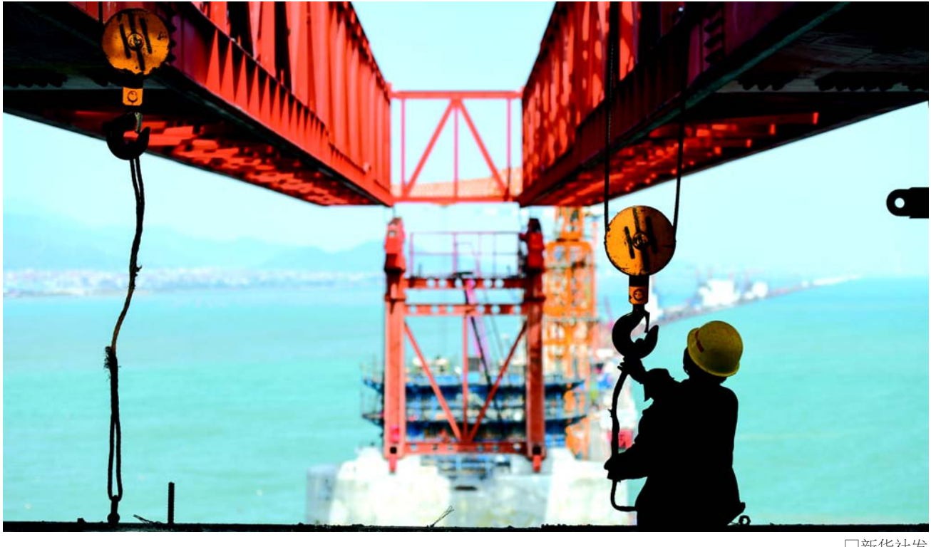
中铁十一局工人在新建福厦铁路湄洲湾跨海大桥建设现场施工(2020年11月2日摄)。 □新华社发
