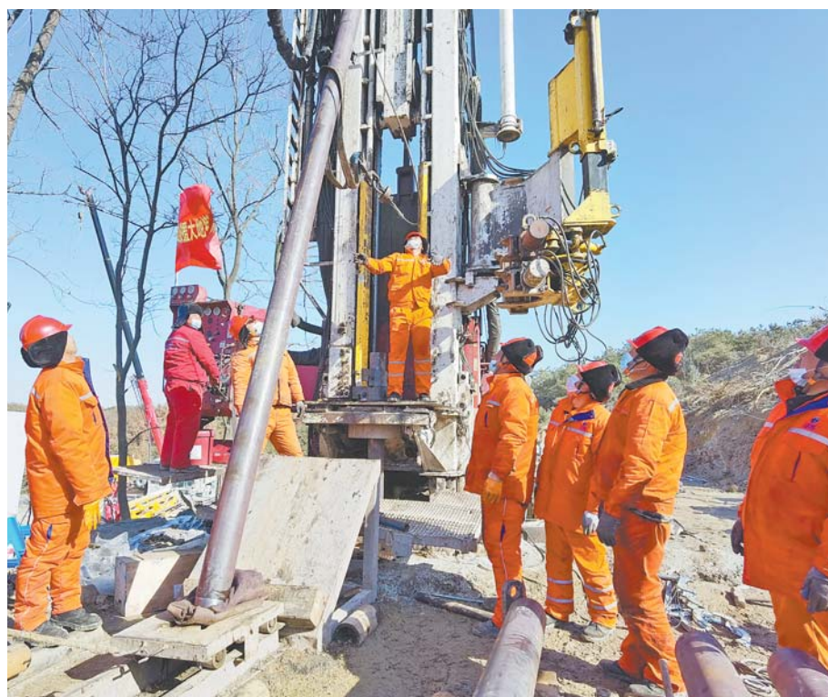
1月18日，栖霞笏山金矿事故救援现场，救援队员在3号钻孔井开展套管下放作业后，随即向井下输送了有线电话。（□记者 王世翔 张楠 报道）
