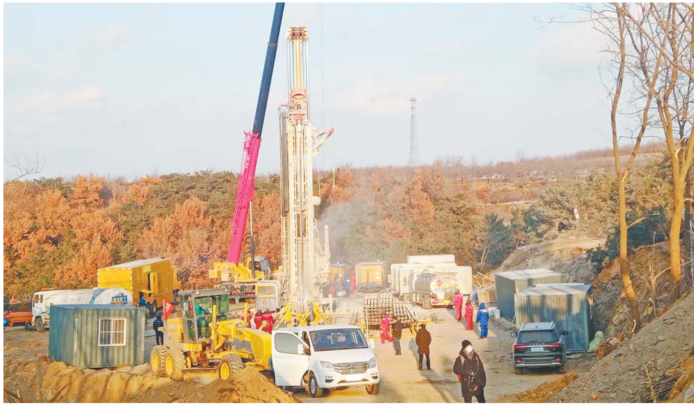
1月16日，栖霞笏山金矿事故救援现场，救援人员正在加紧作业。
