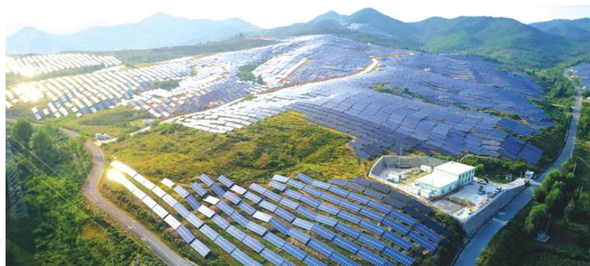
国内首个利用退运电池建设的独立储能电站投运
