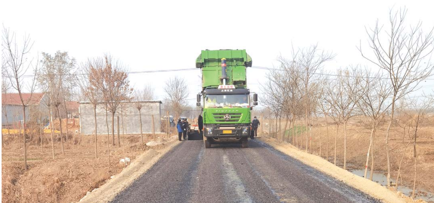
山东省交通科学研究院用新技术修建的乡村示范路。
