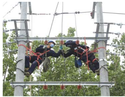
□记者 陈巨慧 报道 施工人员正在进行机井通电项目变压器台架安装。
