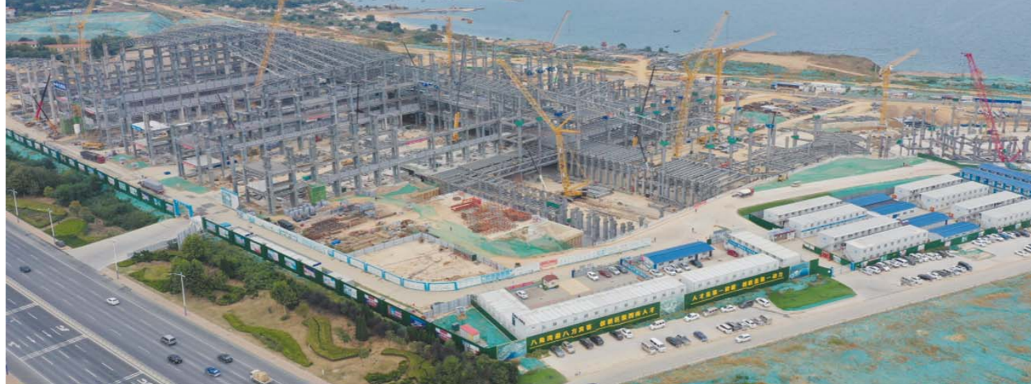
图为八角湾中央创新区施工现场。
