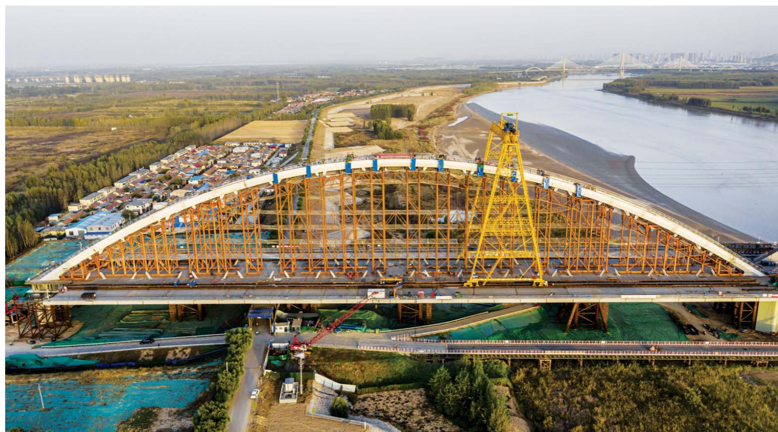
济乐高速南延线顺利通车,凤凰黄河大桥主桥合龙后,由济南城市建设集团负责建设管理的跨黄通道工程又迎来重要节点。10月21日凌晨,齐鲁黄河大桥首跨拱肋顺利合龙。
