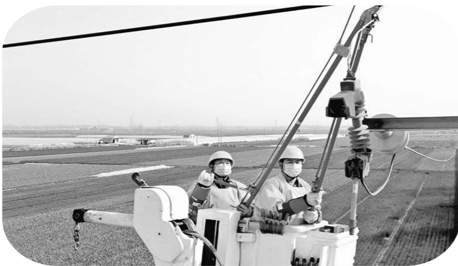
△国网菏泽巨野供电公司带电作业人员为山东黄氏生物科技股份有限公司开展带电接火作业，第一时间满足客户生产用电需求。
