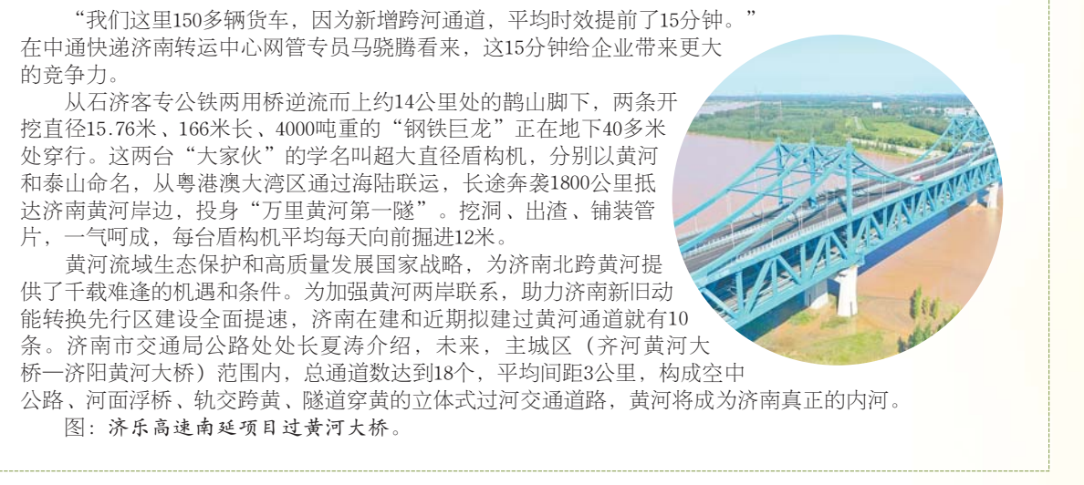
济乐高速南延项目过黄河大桥
