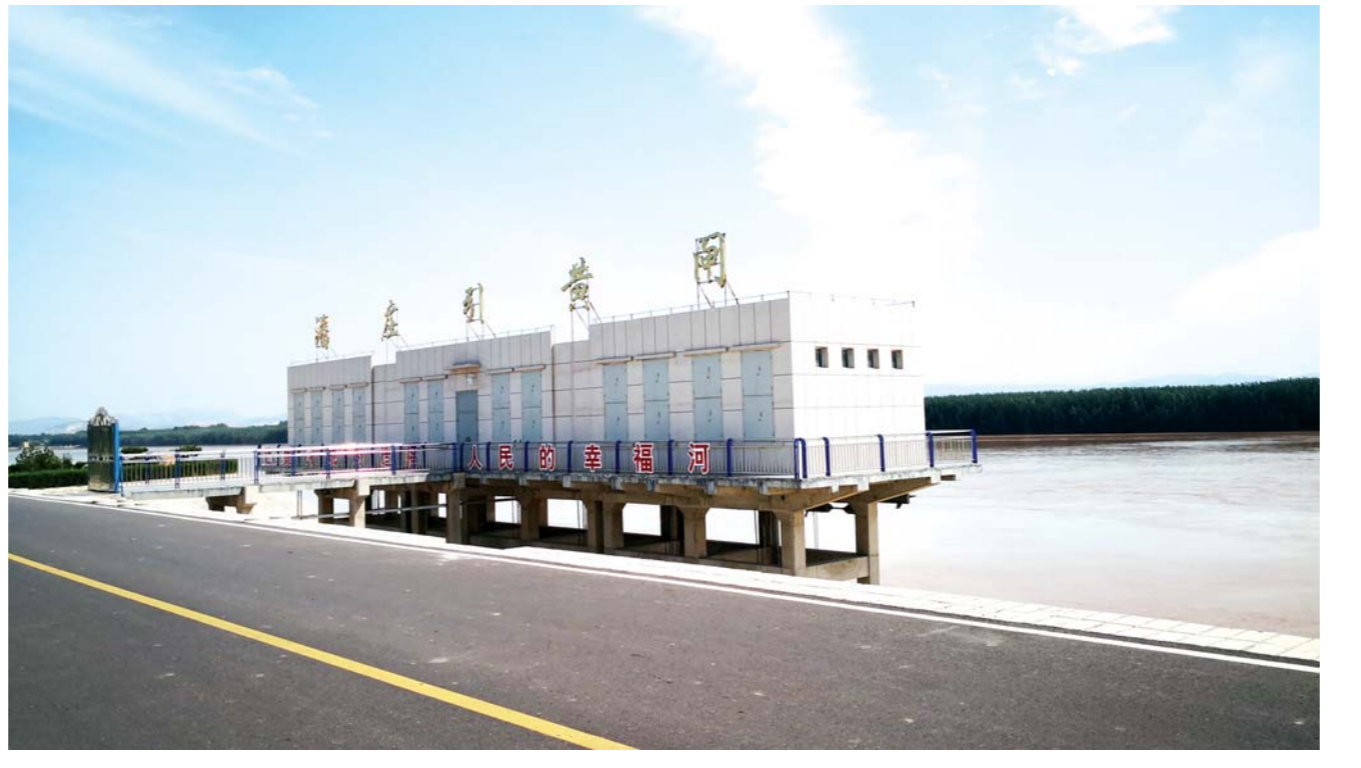
图为全国大型引黄灌区之一的潘庄引黄灌区闸口。
