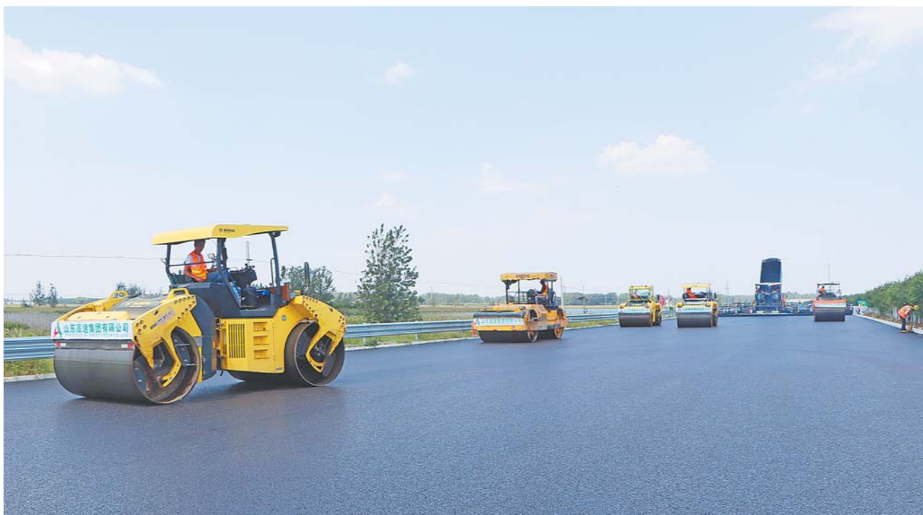
9月3日，京沪高速改扩建工程第八标段正在进行路面沥青摊铺。自2018年1月京沪高速改扩建工程动工建设以来，项目施工方倒排工期，加紧推进工程建设，力争今年年底莱芜至临沂段建成通车。（□记者 常青 报道）
