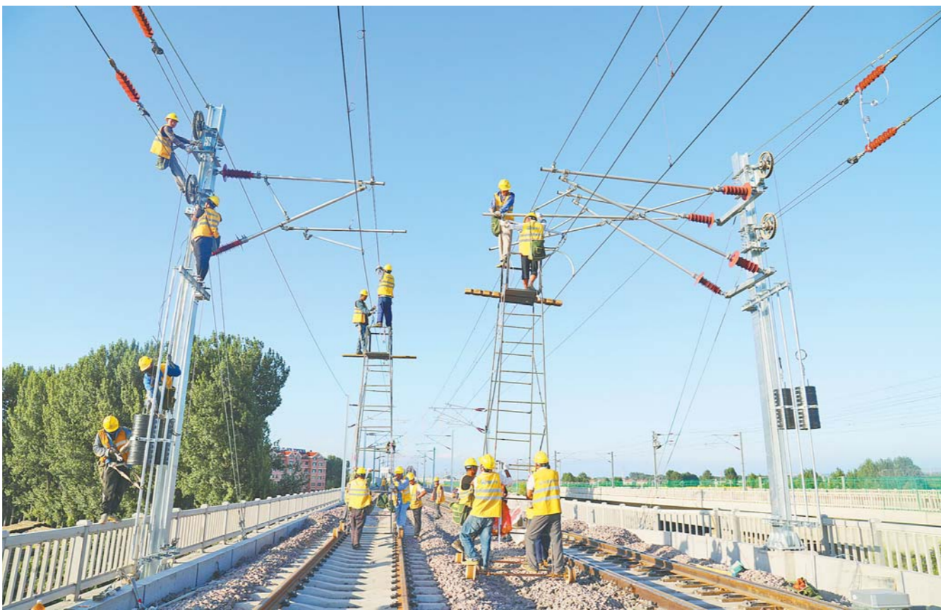
工作人员在潍莱高铁接触网精调作业。(□记者 常青 报道)
