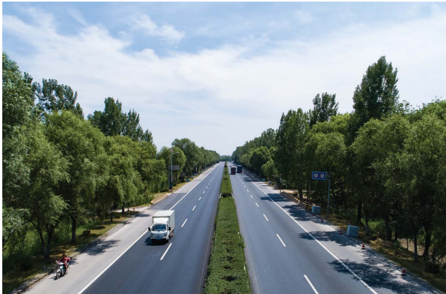
省道240大中修工程主线完工。
