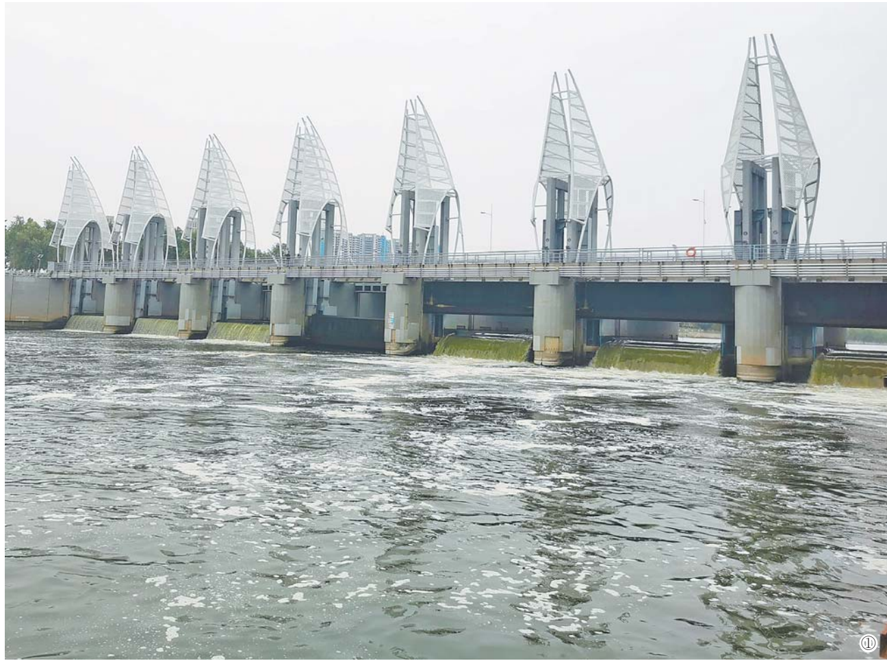
图①：8月1日17时30分，济南小清河洪园节制闸开始提闸放水，降低水位。
