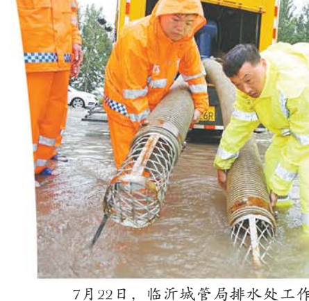
7月22日,临沂城管局排水处工作人员正在操作泵车排涝。(□记者 纪伟 报道)
