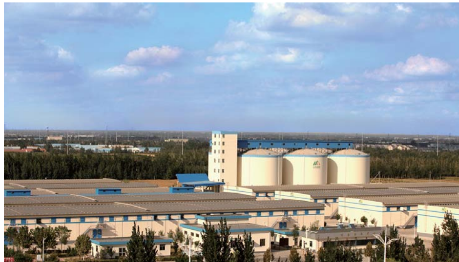
△鲁粮集团鲁中国粮储备库
