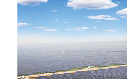
□李明 卫芳 树海 报道 近日，位于东营市河口区百万亩生态渔业区内的曙光汇泰70MW渔光互补产业项目现已全部并网发电。据了解，该项目探索创新了“上能发电、下能养殖”的资源利用新模式，总投资5.7亿元，面积2000亩，日均发电量32万度，可实现年产值1.2亿元，节约24万吨标准煤，对降低东营市的煤炭消耗、缓解环境污染、改善电源结构等具有积极意义。
