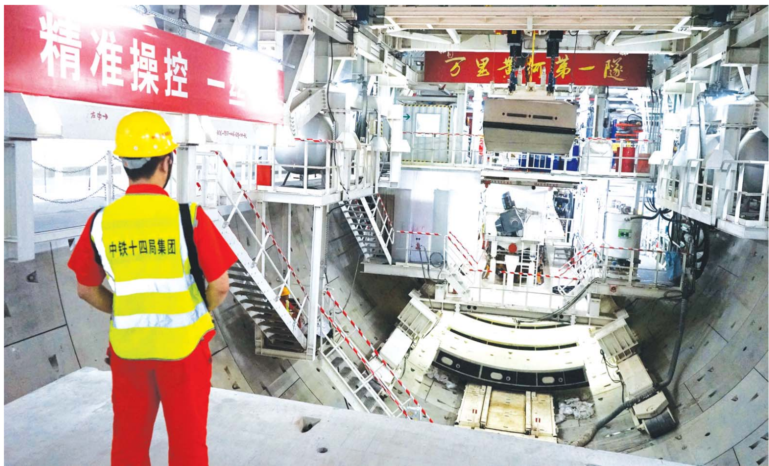
□记者 王健 通讯员 丁翔 报道 济南黄河隧道工程两台超大直径泥水平衡盾构机“泰山号”“黄河号”目前正有序由北向南推进。其中“泰山号”盾构机已经掘进过半。图为现场施工人员从管片运输车吊装管片运送至喂片机。
