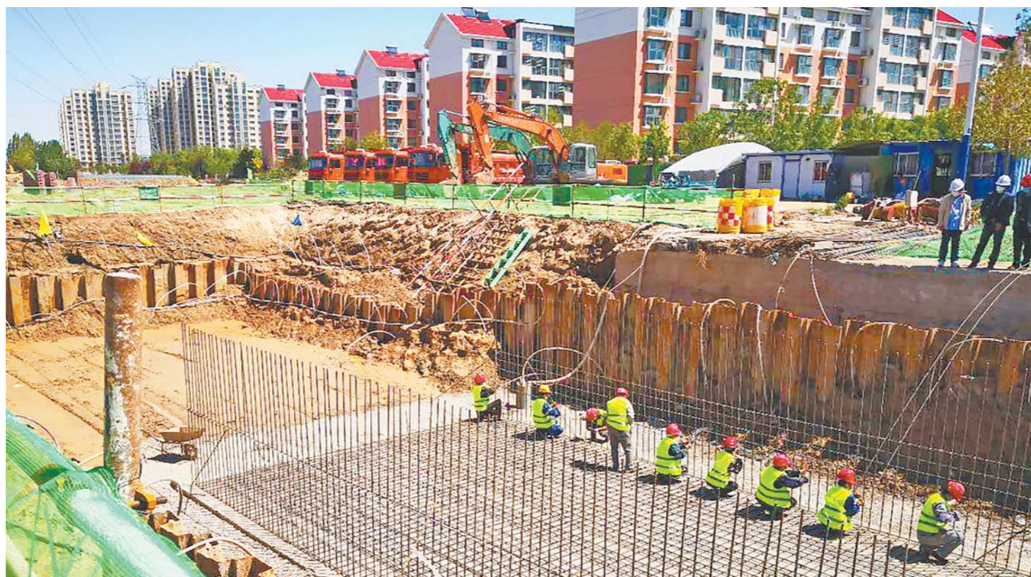
5月20日，东营华山路水系贯通工程锦苑路涵洞正在紧张施工。(□记者 贾瑞君 李广寅 报道)
