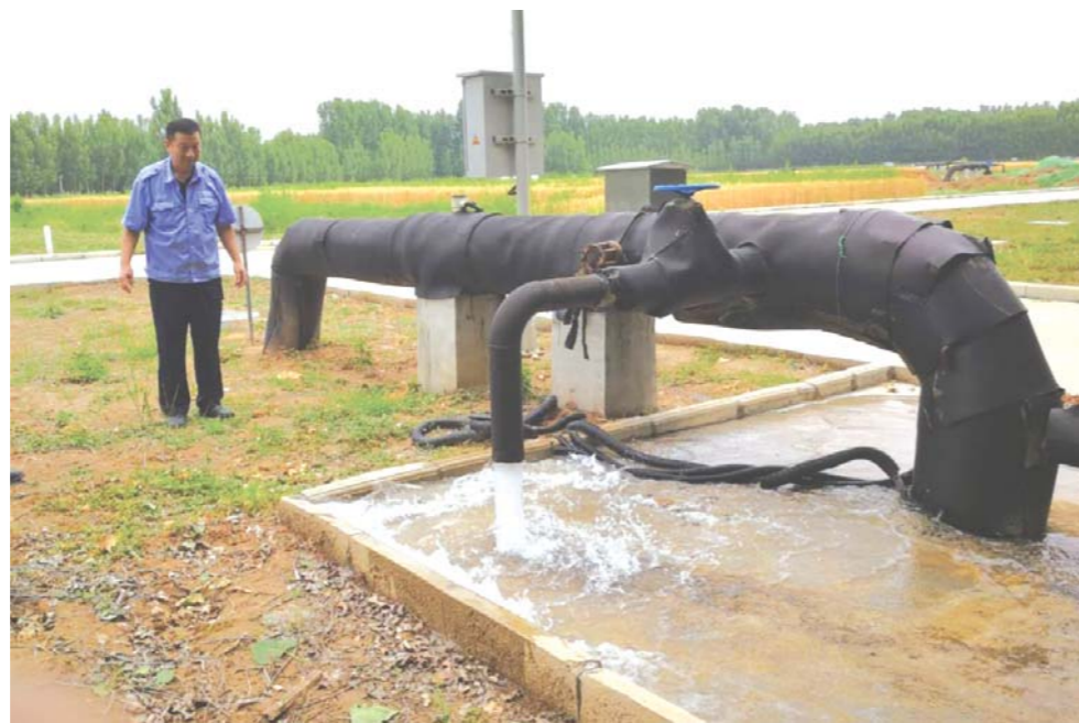
韩庄水源地的这口井深400余米，开闸后清澈的泉水喷涌而出。管理人员称，管子立起来泉水能喷射5米多高。
