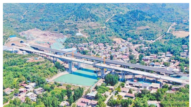
□记者 常青 报道 本报济南6月2日讯 今天，济泰高速公路济南段锦绣川特大桥左幅箱梁架设完成，标志着济南段实现左线全线贯通。济泰高速全线将于年内建成通车。图为济南段航拍图。
