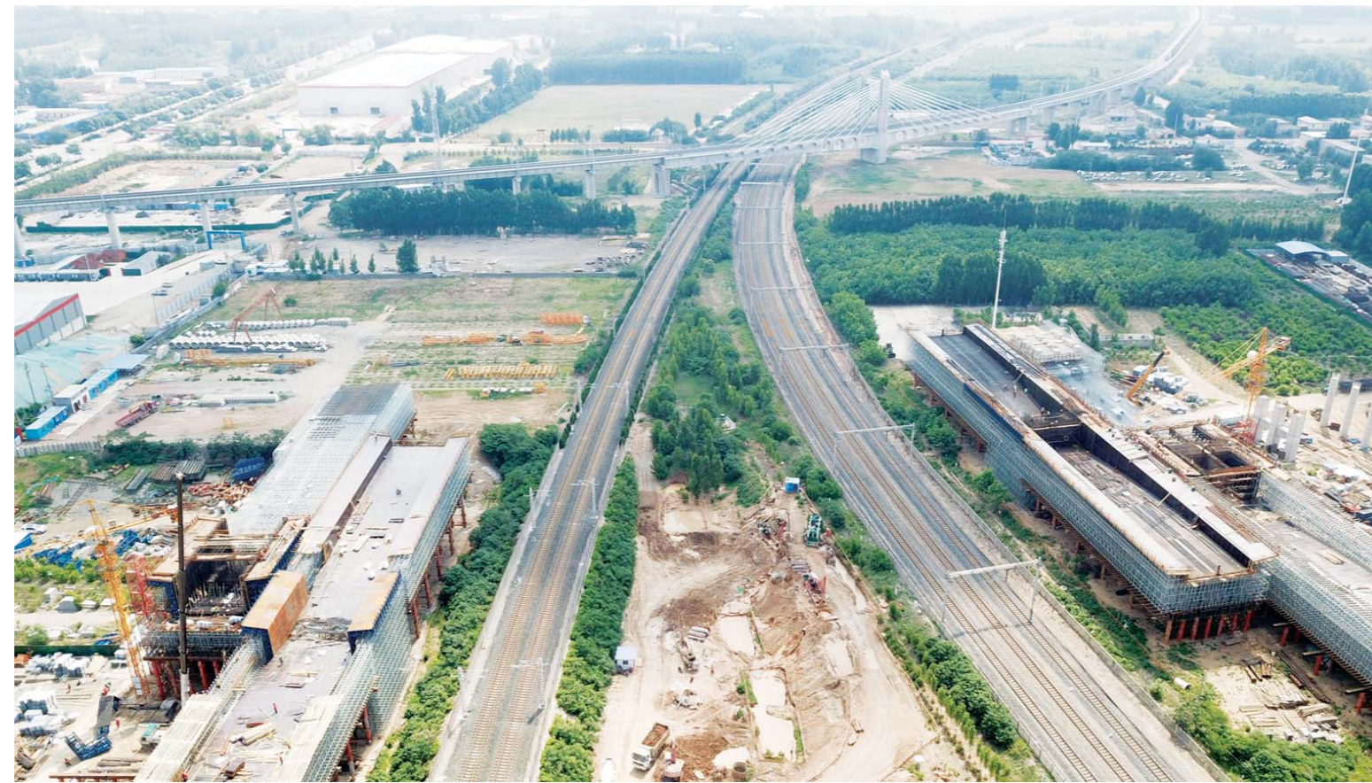
□记者 王健 报道 绕城高速大东环项目作为济南市“三环”率先开工建设的第一段，一直以来备受瞩目。目前，整个大东环项目完成总量的七成以上，路基、桥梁工程完成八成以上，正在按计划快速推进，整个项目预计今年年底前建成通车。 绕城高速大东环项目是济南“三环十二射”高快一体路网规划中“三环”的第一段，真正标志着济南“三环时代”从梦想照进现实。项目主线全长23.594公里，起自青银高速唐王枢纽互通立交，止于京沪高速曹范互通立交，由北向南依次途经历城区、高新区、章丘区，建设标准为双向六车道高速公路，设计时速每小时120公里。项目通车后，将进一步完善东部城区路网布局，有效分流绕城高速公路东线的过境车辆，提高通行效率。
