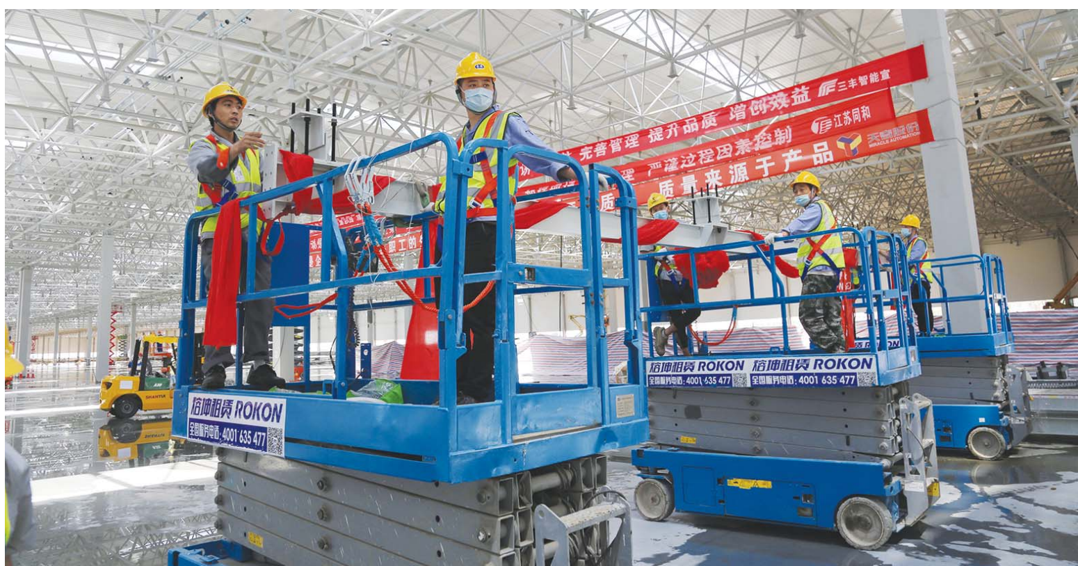
5月18日,长城日照威奕汽车项目总装车间开始进行设备安装,各生产设备预计9月底安装完成。
