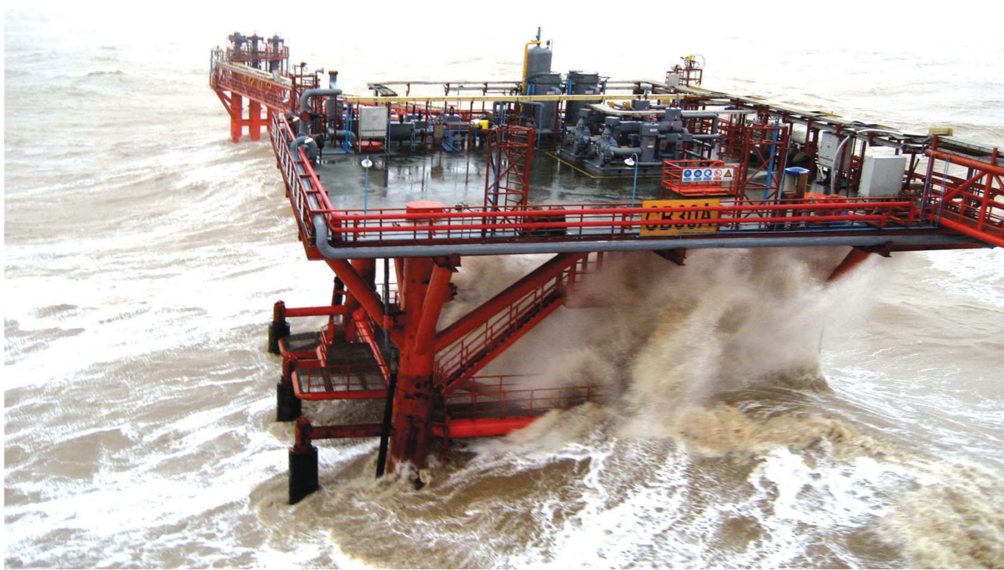
中石化胜利油田埋北30A平台。
