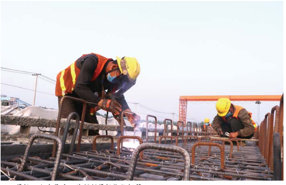
梁场工人为最后一块预制梁板绑扎钢筋。
