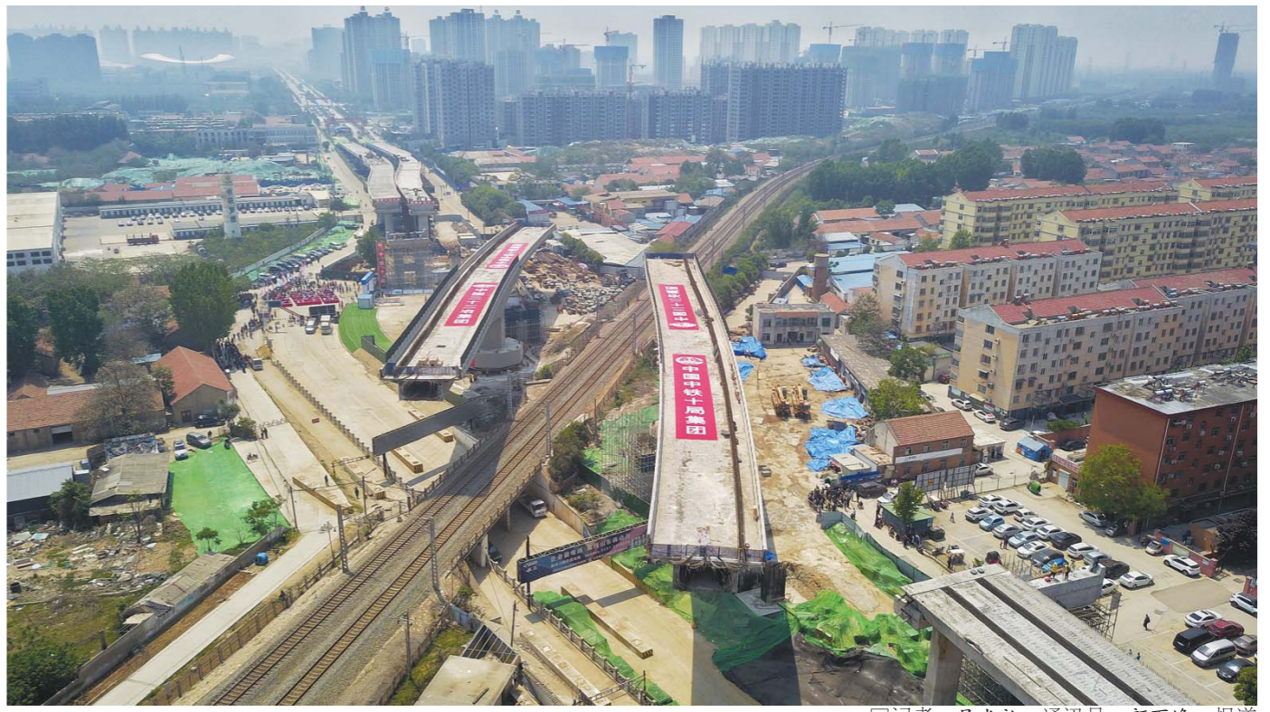
4月30日，济宁王母阁路跨线桥两幅转体梁“比翼双飞”，实现成功转体。
