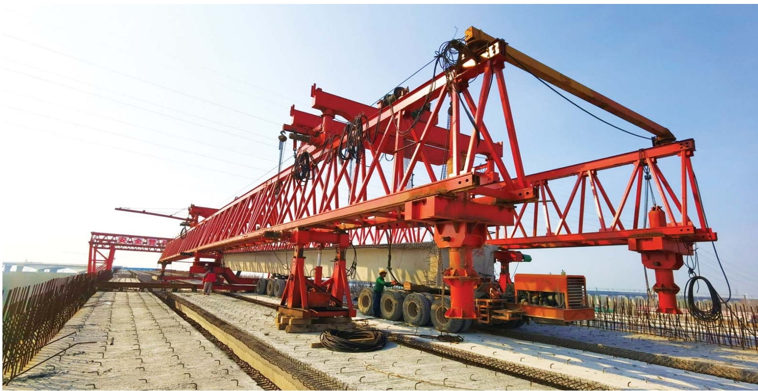
济南“三桥一隧一高速”正加紧推进,图为济乐高速南延项目左幅联通黄河主桥前的预制箱梁架设场景。
