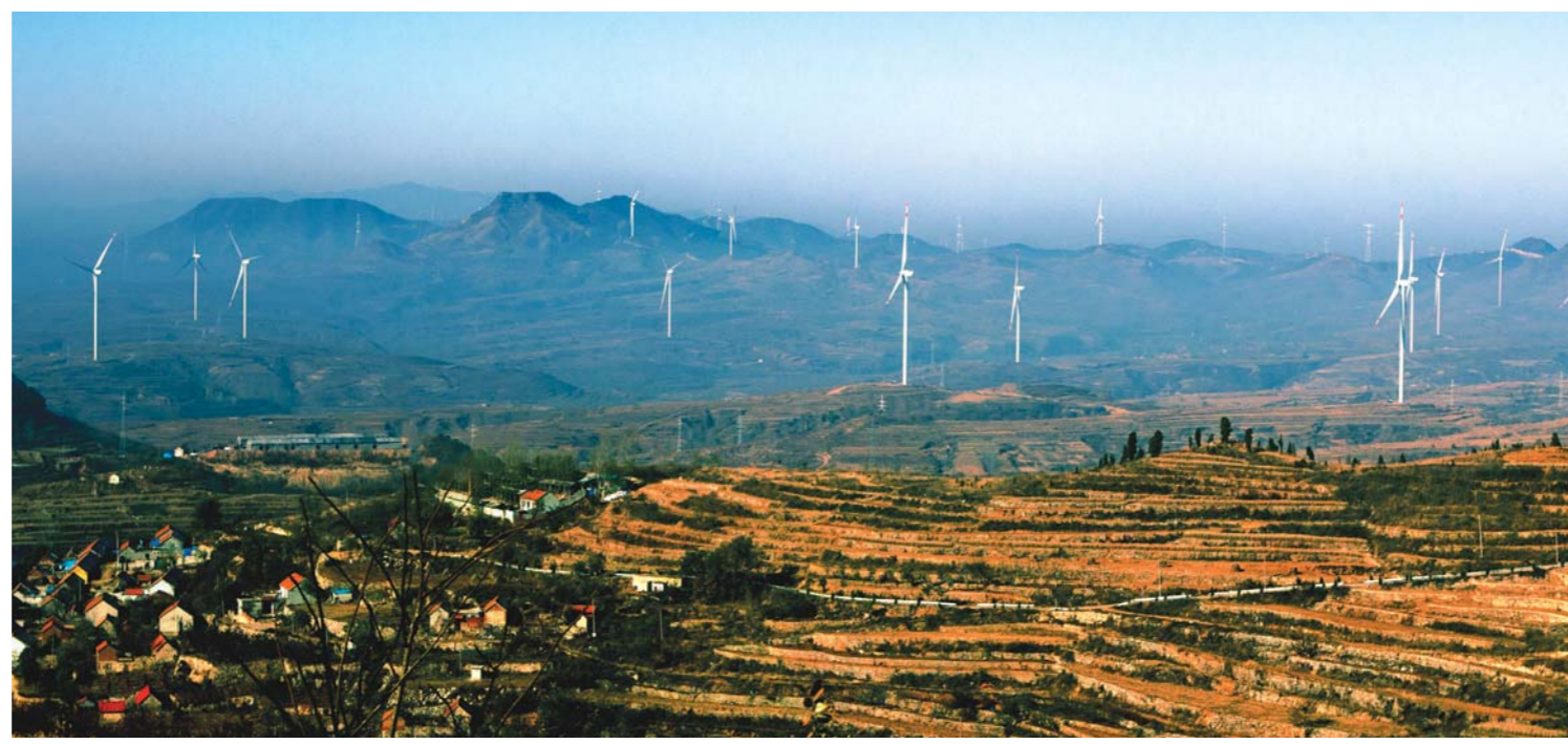
国家电投山东分公司安丘210MW陆上风电项目。
