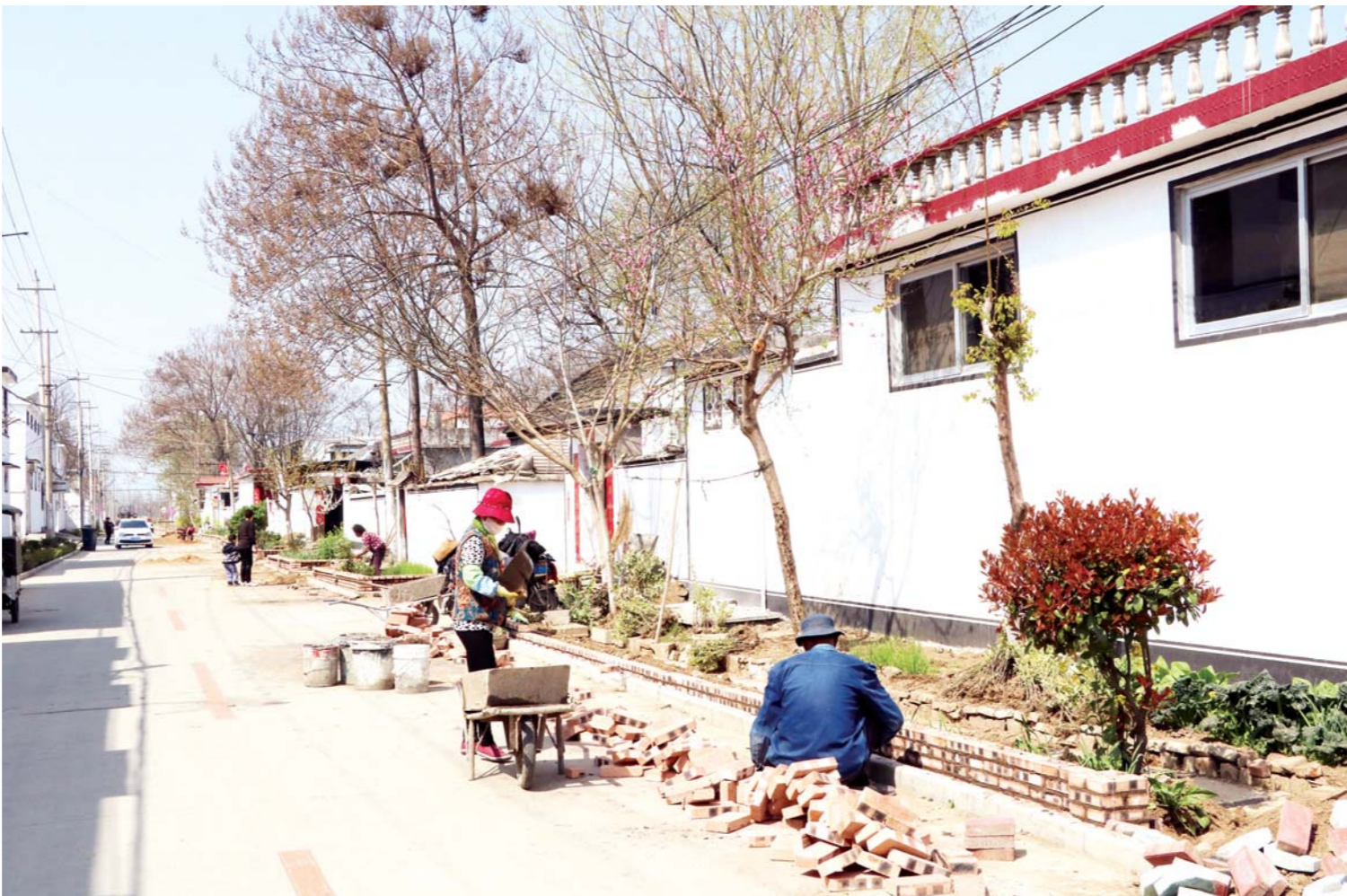
滕州市南沙河镇开展农村人居环境整治,38个村全部行动起来了。图为4月13日,中仓沟村村民正在修砌花池。
