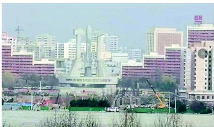
◁远眺平壤综合医院施工工地。(图片来自视频截屏) □新华社发
