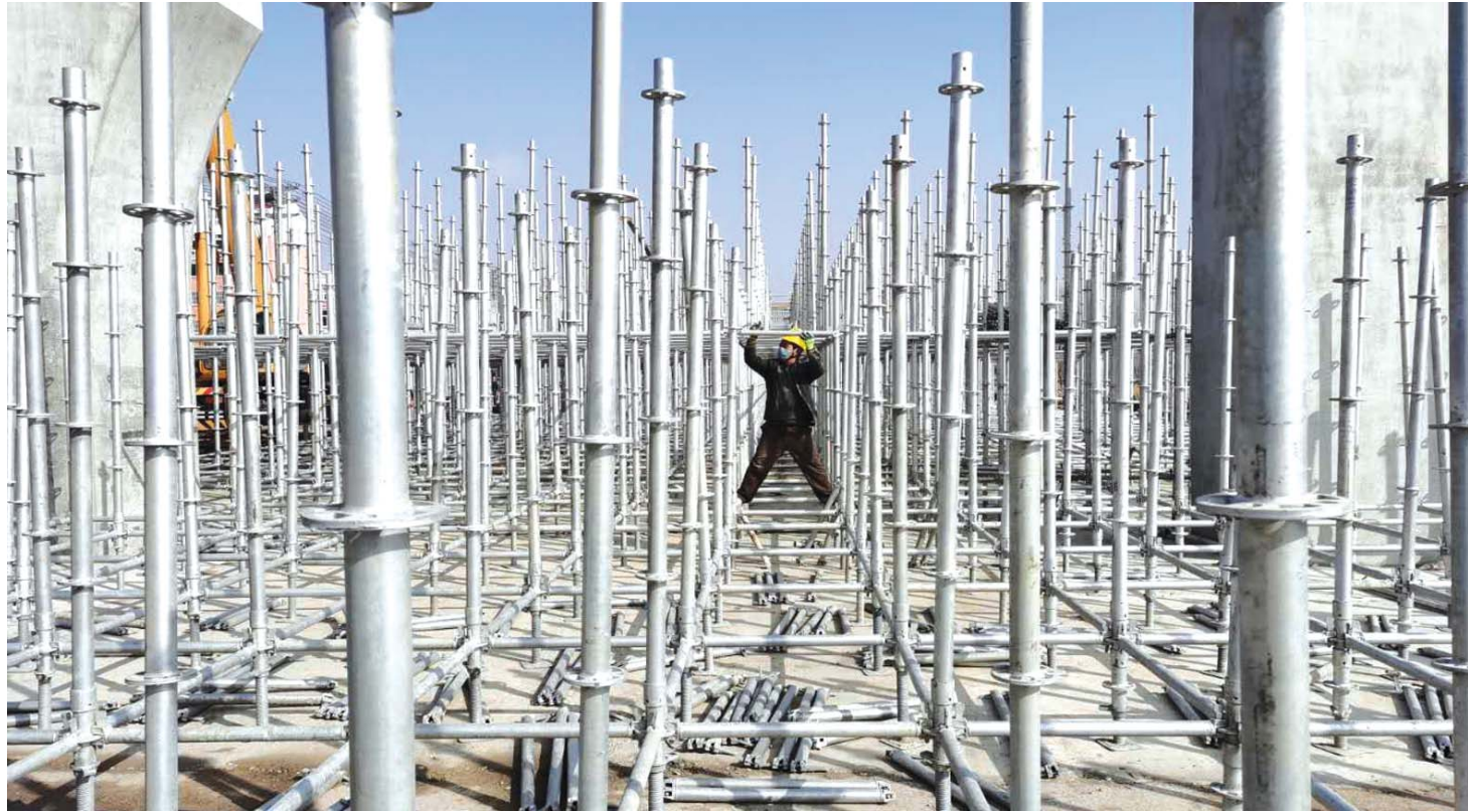
滨州黄河大桥项目建设现场。
