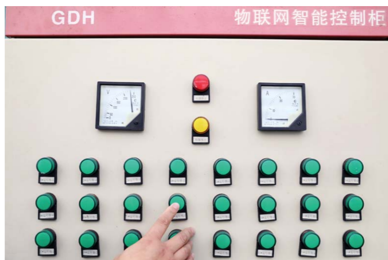
工作人员使用物联网智能控制柜手动控制智能温室中的相关设备，平时大部分设备都由系统自动控制。
