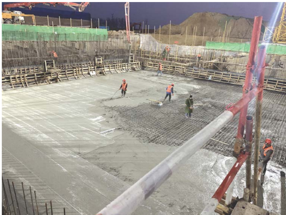
阳信县生活垃圾焚烧发电项目垃圾仓筏板混凝土浇筑现场。
