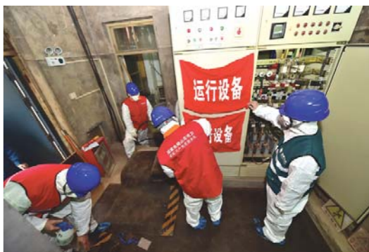
□ 远德亮 报道 淄博供电公司紧急为新冠肺炎定点医院架线双电源。
