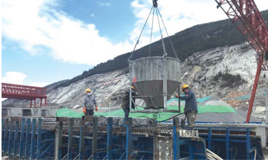
京沪高速临沂段改扩建三标K556+494大桥左幅3-2箱梁顺利浇筑。
