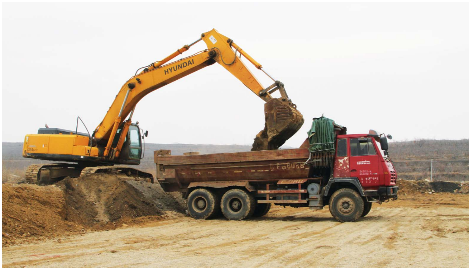
□ 通讯员 言芳 保帅 克勤 晓明 报道 2月24日上午,栖霞市分别在经济开发区奥朗机械一期项目、庄园街道玫瑰悦府项目、翠屏街道TPU新材料产业园项目现场(上图)举行项目集中开工仪式。一大批涉及智能制造、医用器材、新型包装材料、环保设施、矿山技改扩能等领域的高端项目,将为栖霞市工业经济注入新动能、架起新框架。
