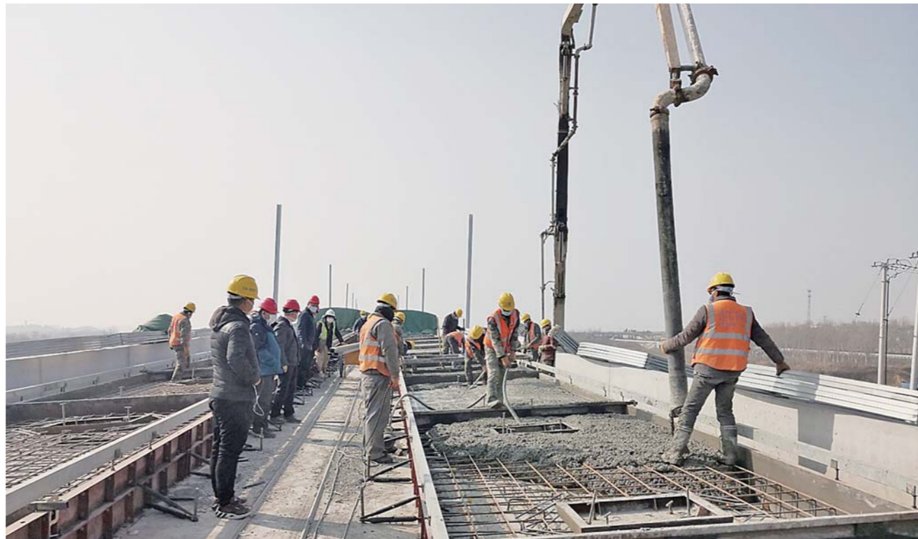
2月13日，省重点工程项目潍莱高铁施工现场，工人们正紧张有序忙碌。据了解，目前，我省在建高铁项目已按计划陆续复工。
