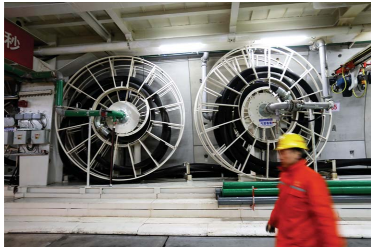
各种管线随盾构机往前推进，现代化的盾构法施工现场井然有序。
