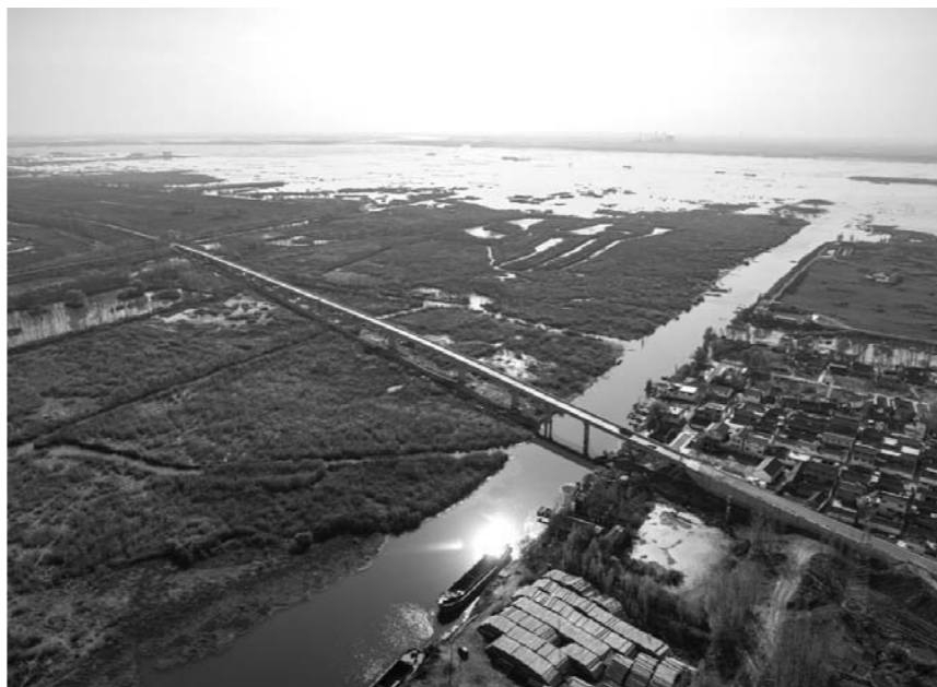
12月5日,环湖大道东线工程城郭河段航拍。
