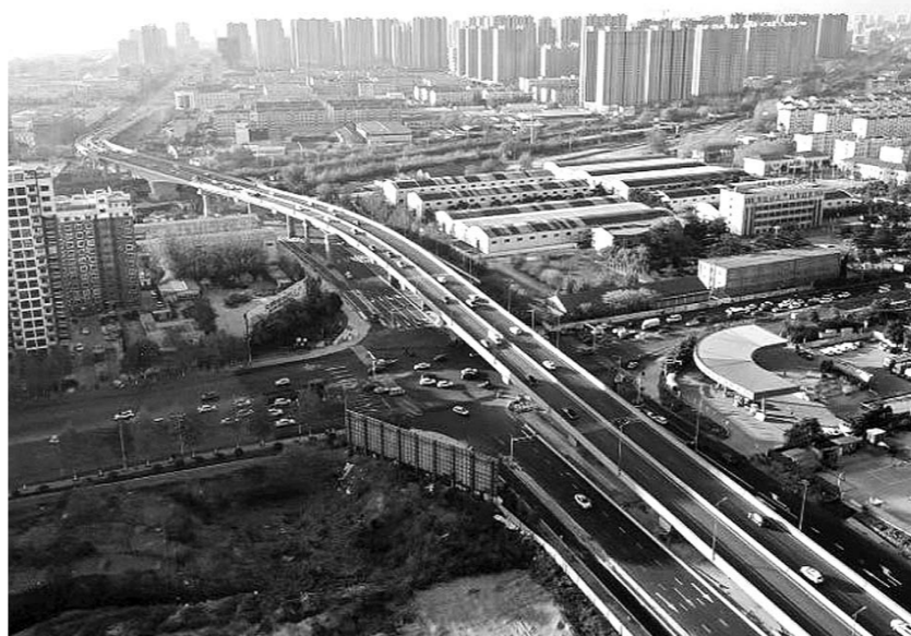
建成通车后的火炬路跨线桥。
