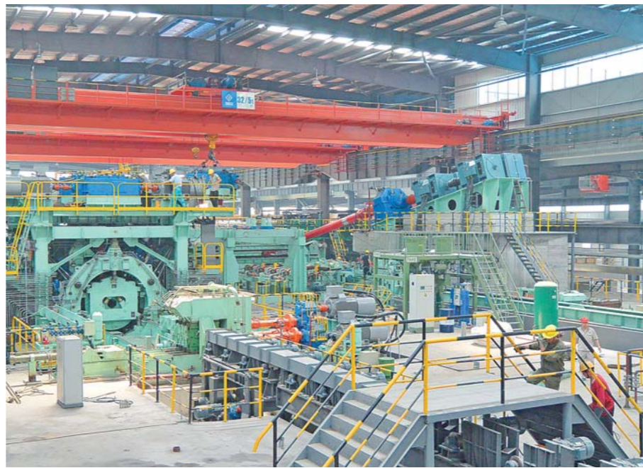
图为临沂金正阳管业有限公司高端合金管材智能制造项目。
