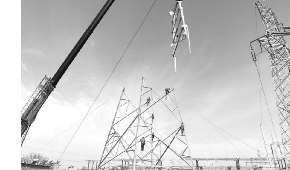
12月11日,济宁东部电网改造工程220千伏罗彦线、罗宿线恢复送电,标志着长达46天的重大停电施工改造任务完成...
