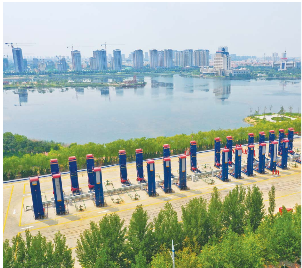
位于滨州市省级湿地公园白鹭湖东岸的白鹭湖井工厂，共有48口油水井，深蓝色的皮带式抽油机整齐排列，伴随着水波和湖风有节奏地运转着，形成一道独特的工业生态和谐共生的美景。
